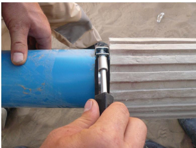
*Рис. 3. Крепление верхнего ограничительного хомута*
