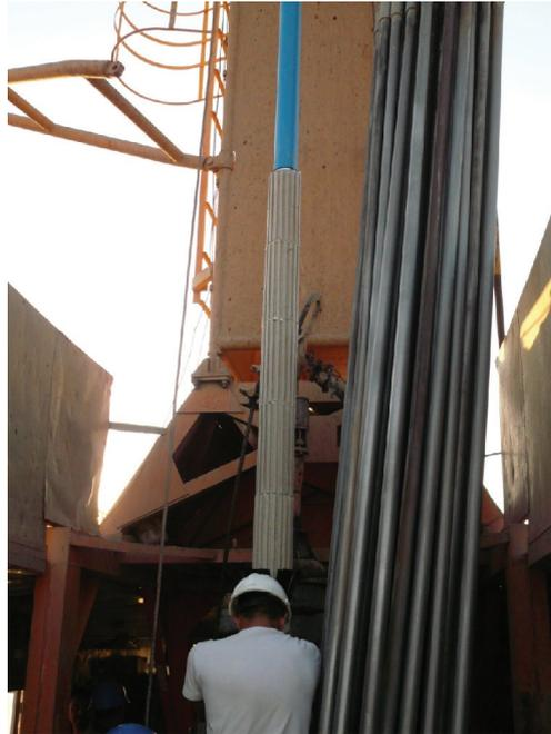
Рис. 4. Спуск обсадной колонны с набором бентонитовых гильз в скважину
