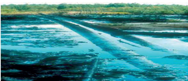
Рис. 4. Разлив нефти из-за трещин на трубопроводе
