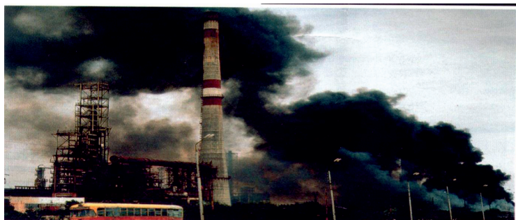
Рис. 1. Авария на нефтегазовом комплексе
