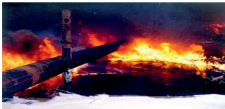
Рис. 2. Авария на трубопроводе сопровождение с пожаром
