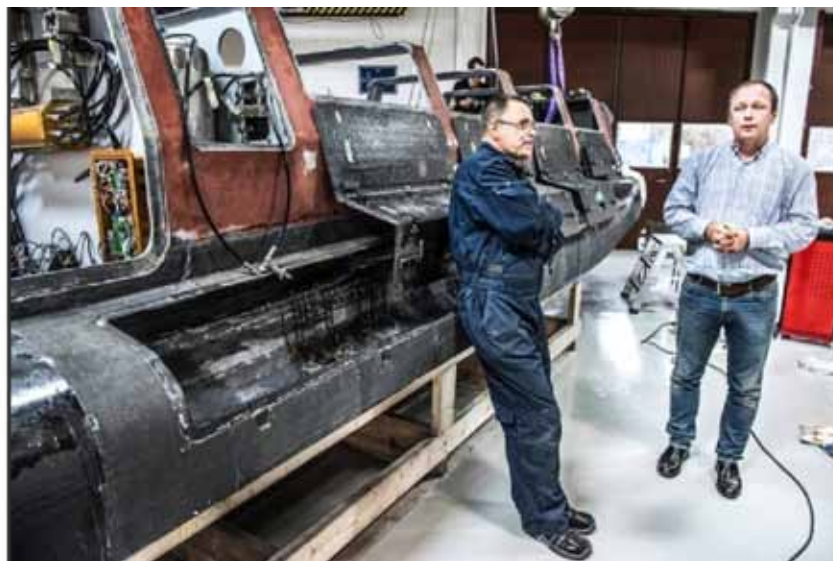
Рис. 2. Строительство ПСД SEAL Carrier
