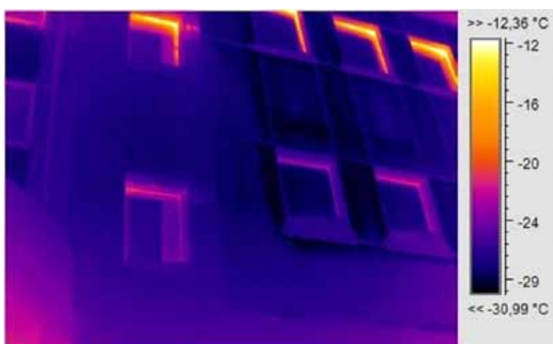
Рис. 3. Передняя сторона УЛК (2-й и 3-й этаж)
