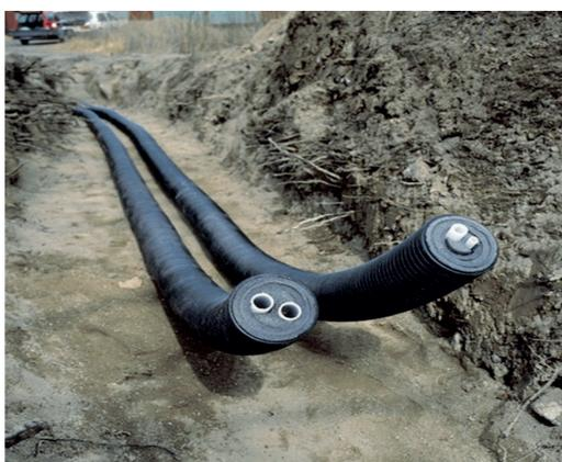
Рис. 1. Изолированные теплопроводы экофлекс
